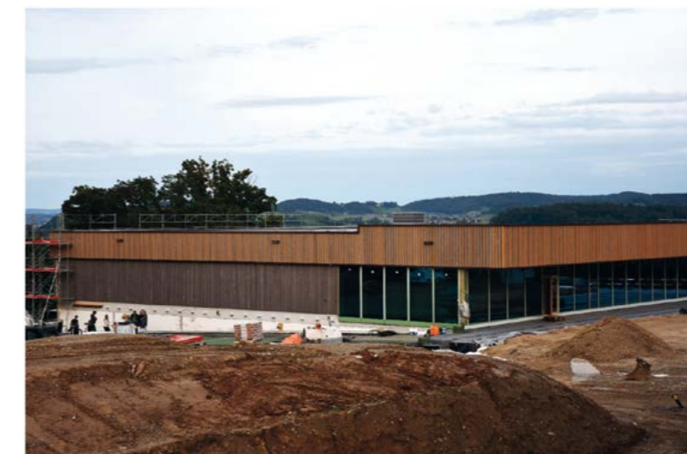
Neue Mehrfachturnhalle von Aussen
