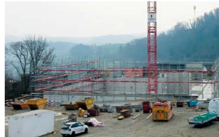
Tagesaktueller Blick auf die Baustelle des Areal Chapf am 26.03.2025 – Das Gebäude wächst langsam in die Höhe. Nach den Frühlingsferien wird der Pavillon, das langjährige Provisorium, abgerissen.
