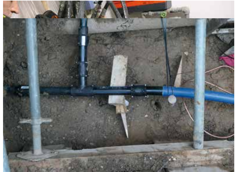
Das von Fritz Streuli montierte T-Stück mit verschweissten Plastikmuffen
