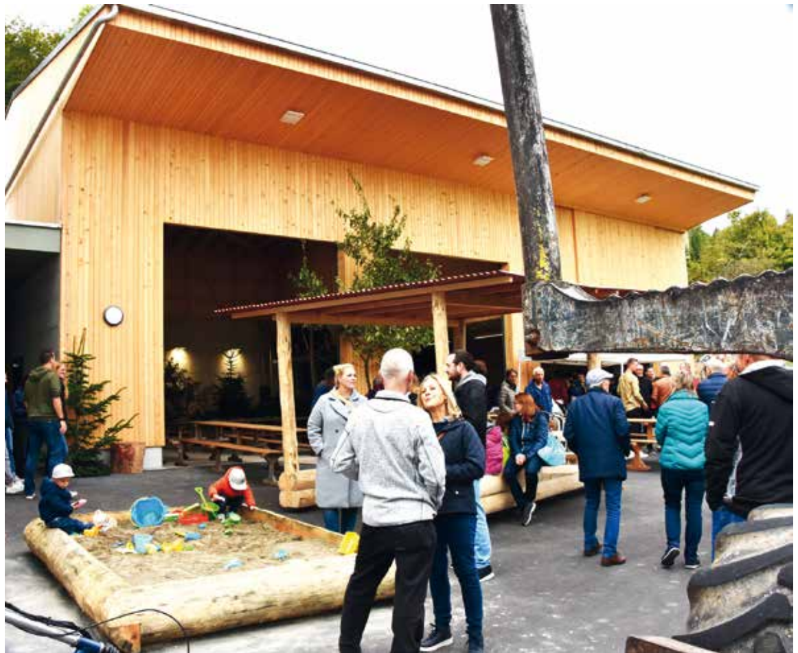
Der neue Werkhof in Hüntwangen
