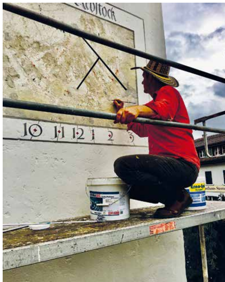
Einer der Maler von Maler Stegemann bei der Renovation Bilder zvg
