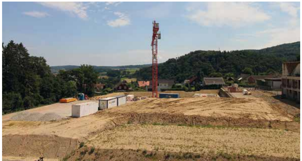
Baufortschritt per Dato 21.07.2024
