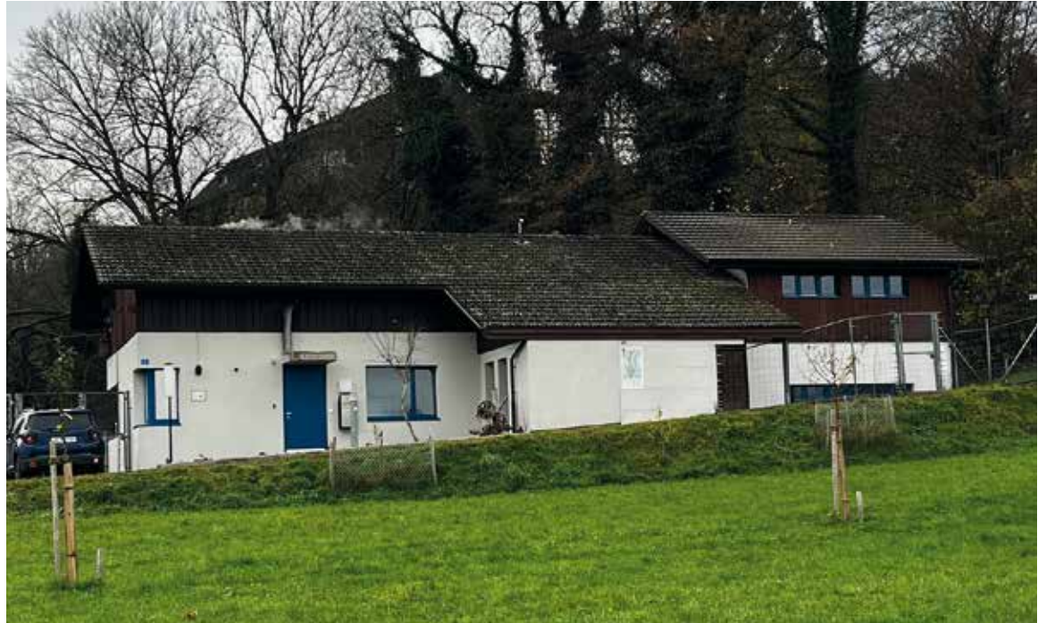
Mit der Einweihung der Abwasserreinigungsanlage ARA «in Chratzeren» im Jahr 1974 konnte die erste erfolgreiche Zusammenarbeit zwischen den Gemeinden Buchberg und Rüdlingen nach der Trennung 1839/40 abgeschlossen werden. Bilder klü
