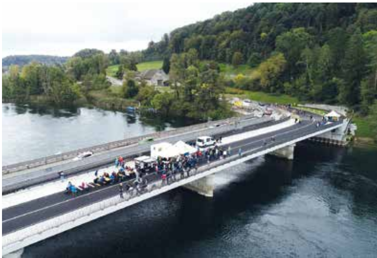
Die neue Brücke (vorne) wiegt circa 2200 Tonnen - Bilder von Otto Haller
