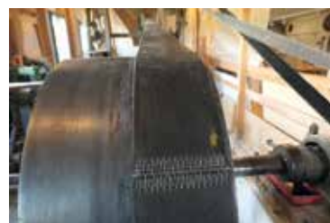
Fertig reparierter Flachriemen auf der Antriebsriemenscheibe
