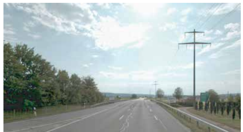
Im Sommer 2023 wird die Strasse von Eglisau nach Rafz für sieben Wochen wegen Belagerneuerung komplett gesperrt. Bild zvg
