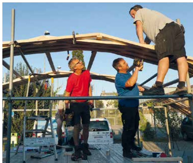
Zusammenfügen und befestigen der Brückenbogen.
