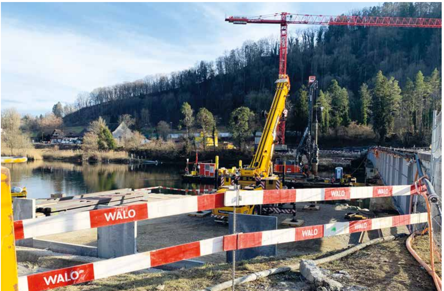
Der Brückenneubau von Rüdlingen nach Flaach ist in vollem Gange - Foto von Janine Dean
