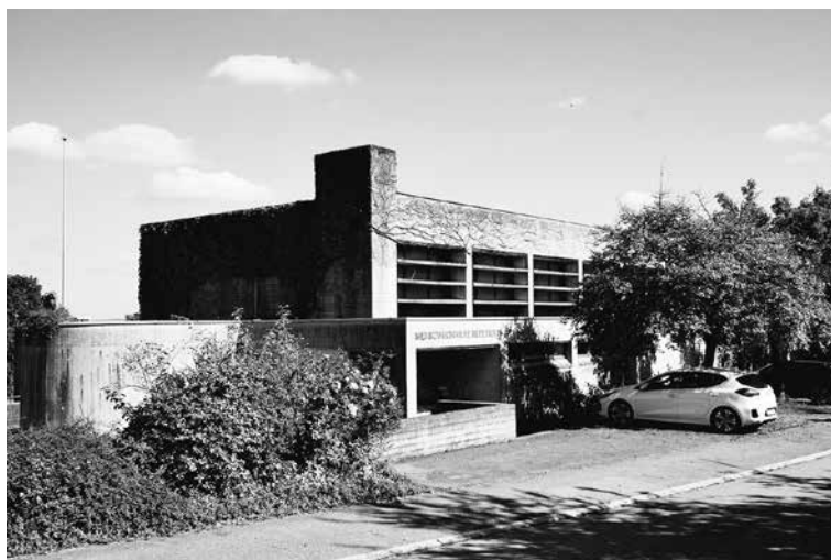
Die sanierungsbedürftige Mehrzweckhalle in Rüdlingen
