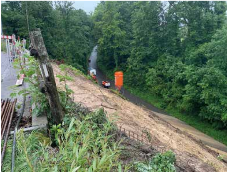
Hangrutsch an der Grabenstrasse von Karin Lüthi
