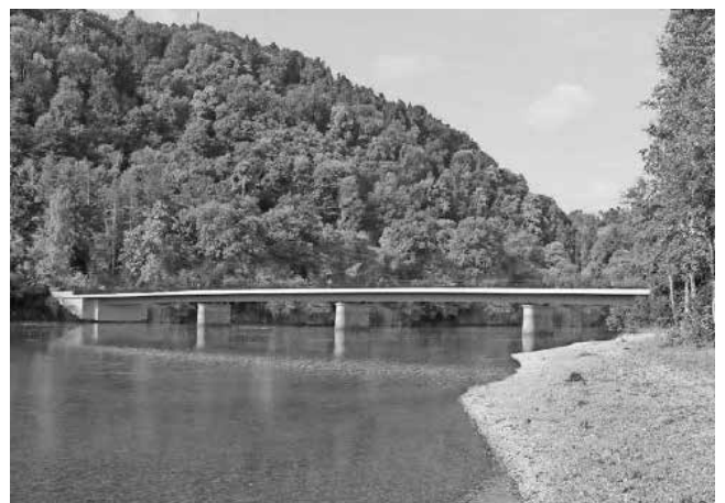
Die geplante, neue Brücke
