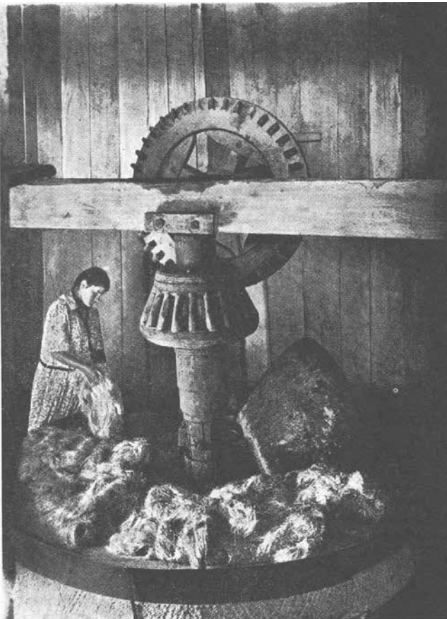
Die Hanfreibe unterhalb der Eichmühle in Hettlingen ist ein Besuch wert. Sie wurde mit einem Wasserrad angetrieben.
