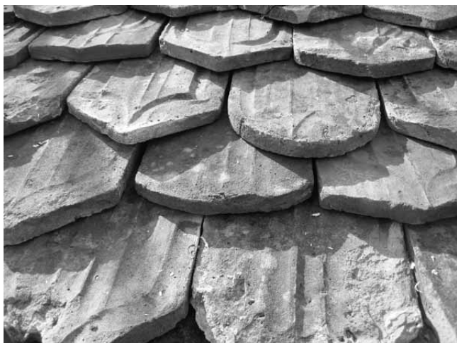
Verlegte, handgemachte Biberschwanzziegel auf dem Dach des Handwerksmuseums Gattersagi Buchberg
