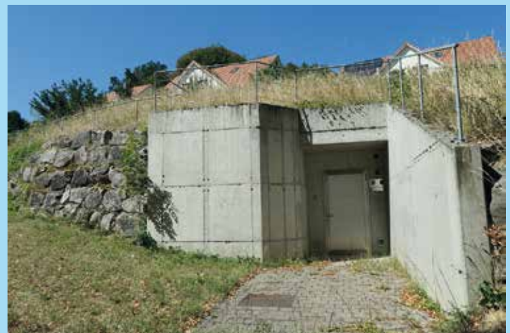
Reservoir und Stufenpumpwerk Förlibuck
