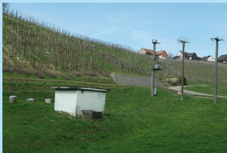
Die 1920 erstellte und 2008 stillgelegte «Pumpstation Bach» mit Stromzuleitungen
