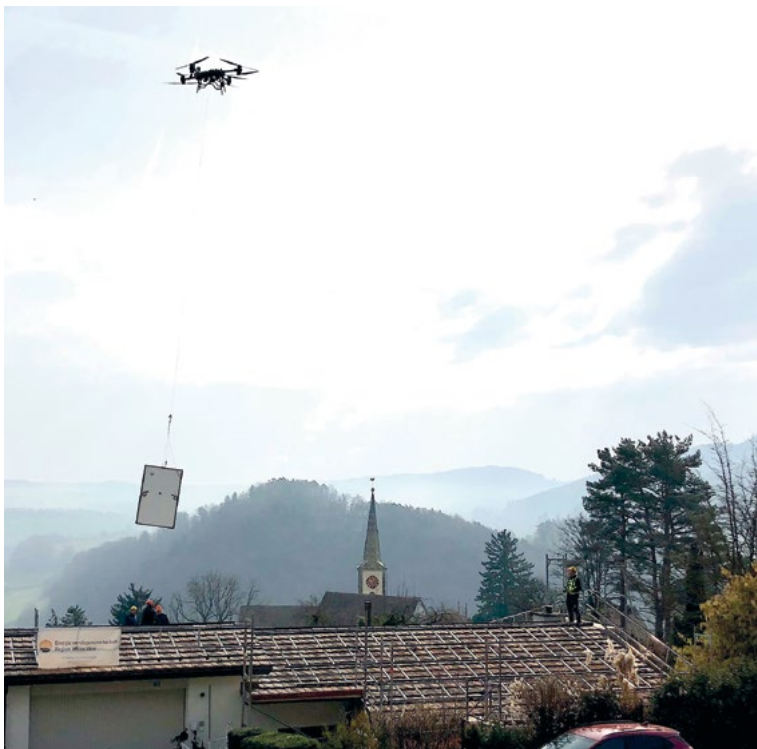
Die moderne Art, Solarpanels zu liefern - rechts unten auf dem Dach: Der Pilot der Drohne. Beobachtet von Toni Saller
