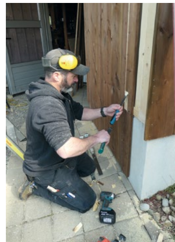
Holzbau ist seine Leidenschaft: Stefan Wüst an der Arbeit
